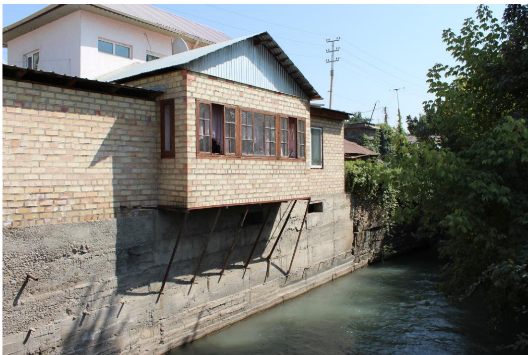
Рис 11. Строительство в водоохранной зоне рек запрещено. Не смотря на это, жители часто нарушают правила и возводят капитальные строения непосредственной близости к рекам.
