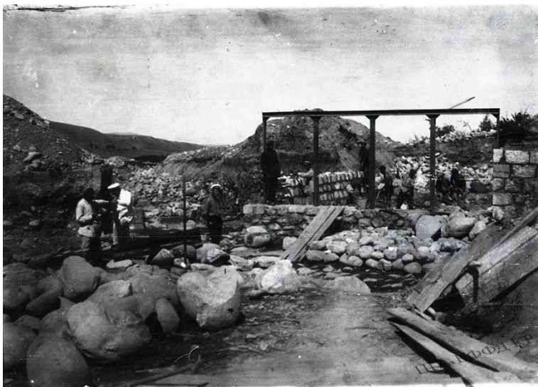
Рисунок 2. Строительство головного сооружения арыков Туш и Джантай. Дата съемки неизвестна. ЦГА КФФД КР
