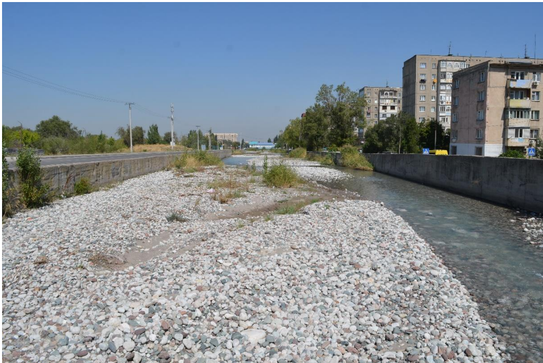
Рисунок 9. Высокие бетонные стены поймы реки Ала-Арча вдоль ул. Малдыбаева. (фото Тагаева К.)
