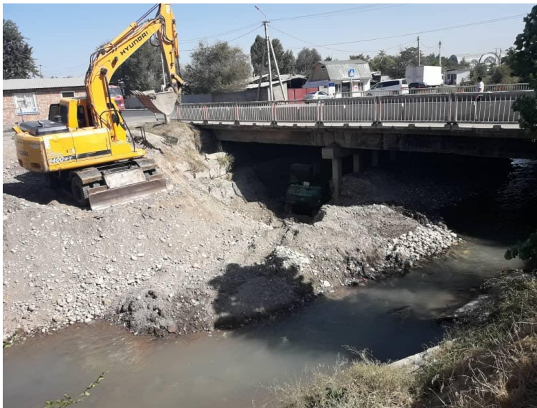
Рисунок 4. Механизированная очистка русла реки Ала-Арча под мостом на улице Рыскулова (2018). Фото взято из сайта КНИА «Кабар».
